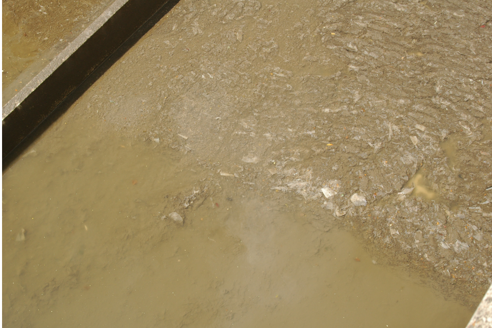
Abbildung 8: Sohle eines Rechteckbeckens (Durchlaufbecken im Nebenschluss) /9/
