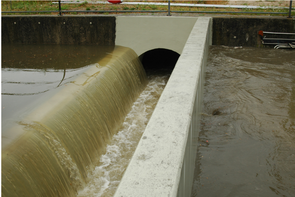
Abbildung 7: Beckenüberlauf eines Rechteckbeckens (Durchlaufbecken im Nebenschluss) /9/
