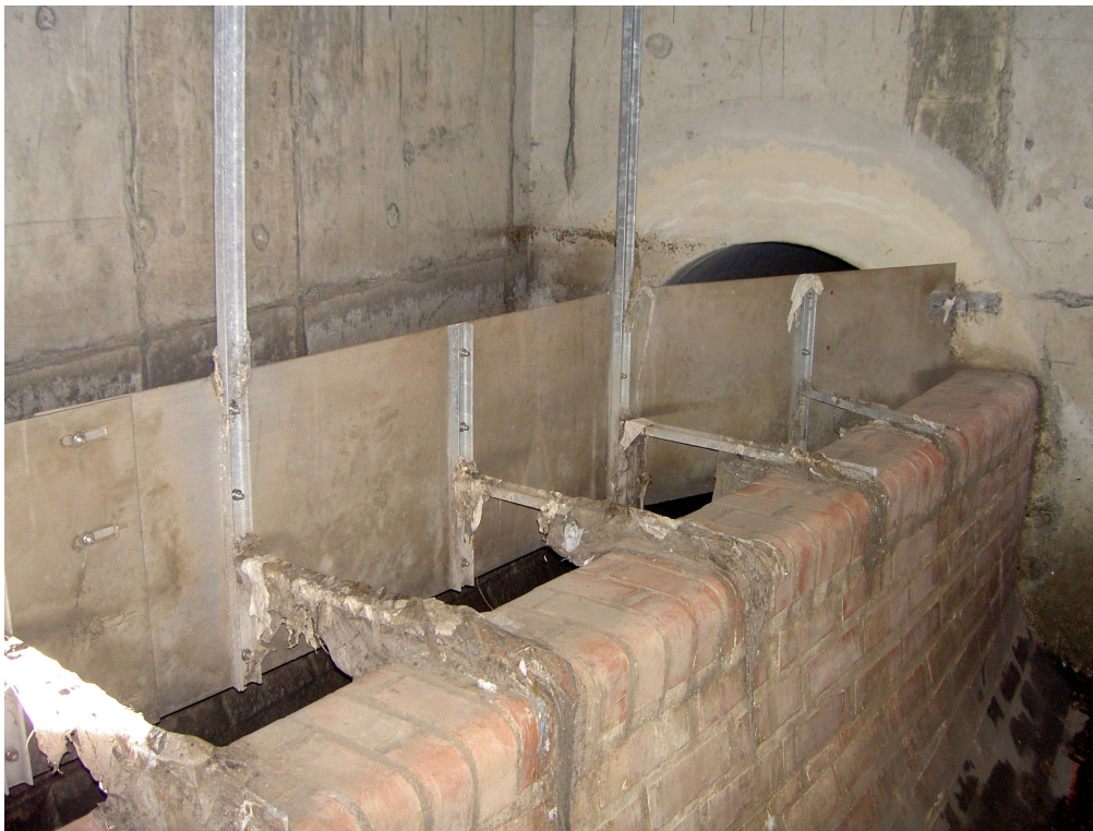
Abbildung 3: RÜ mit Tauchwand im Bereich der Trockenwetterrinne
