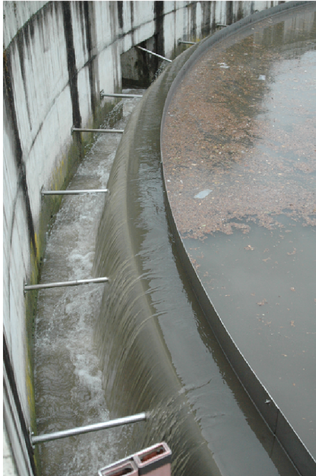
Abbildung 9: Klärüberlauf eines Rundbeckens (Durchlaufbecken im Nebenschluss) /9/
